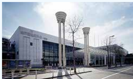
神戸国際会議場外観
